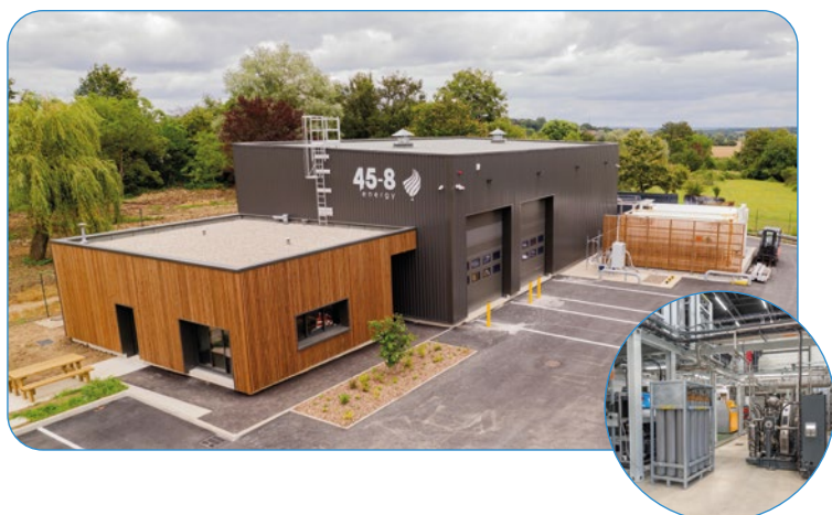
Vue drone de l'unité pilote de production d'hélium de 45-8 ENERGY
